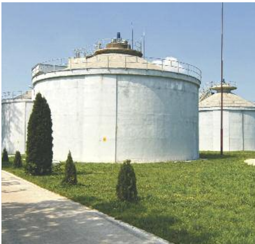
Stația de epurare: metantancuri reabilitate
