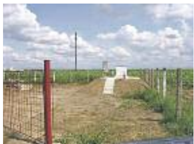
Puț de captare a apei reabilitat
