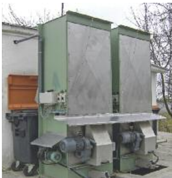
Stația de pompare a apelor uzate SP Micro 17: grătare automate reabilitate
