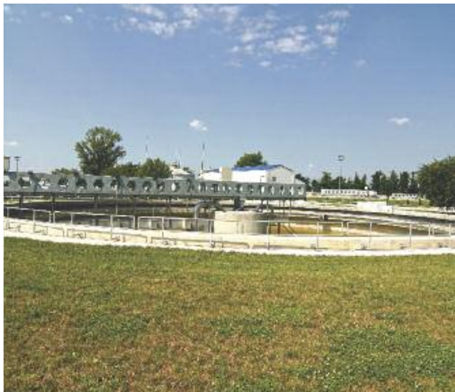
Stația de epurare: decantor primar reabilitat
